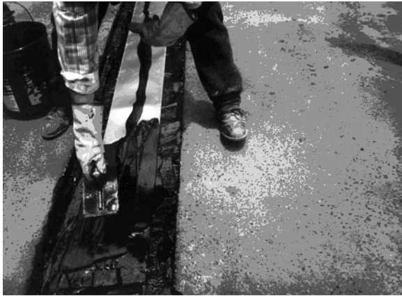
Foto 9. Construcción de una junta asfáltica. Puente Río Negro.
