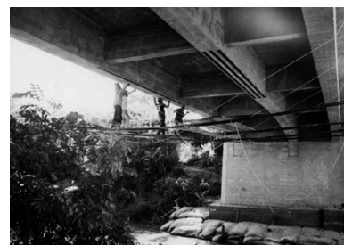
Figura 51. Refuerzo a flexión mediante fibras de carbono. (Fuente: SIKA - Colombia)
