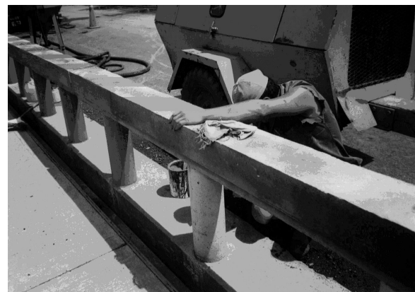
Figura 18. Reparación del concreto de la baranda y su correspondiente pintura
