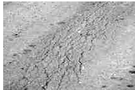
Figura 6. Carpeta descompuesta, grietas de cocodrilo. Puente la Criolla
