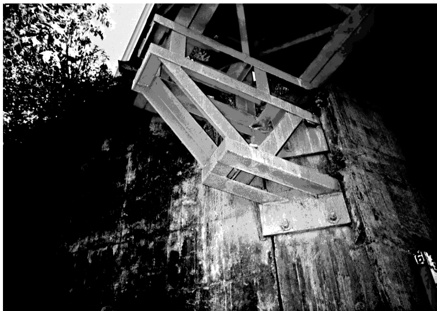
Figura 24. Soporte de una pasarela, que no afecta estabilidad estructural de la aleta.
