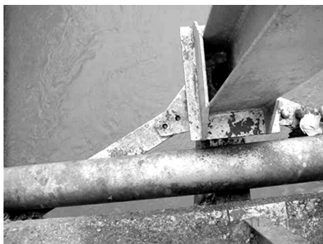
Figura 55. Corrosión
