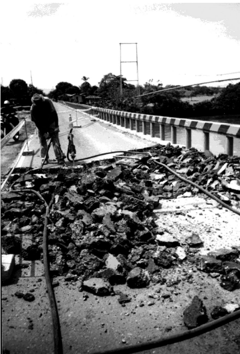
Figura 7. Demolición de carpeta asfáltica. Puente Río Negro.
