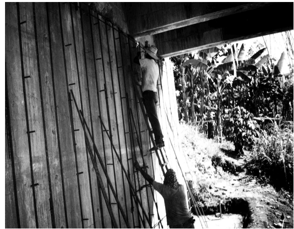
Figura 28. Encamisado estructural de estribo. Puente Río Negro
