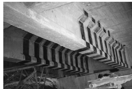
Figura 49. Refuerzo a cortante con fibras de Carbono. (Fuente: SIKA - Colombia)
