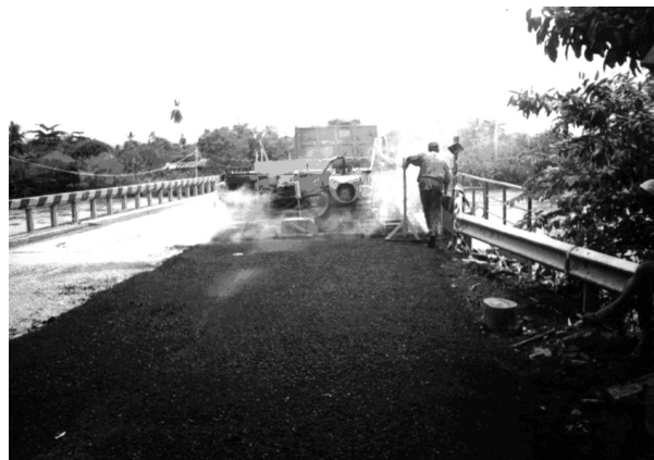
Figura 8. Extendido de la nueva carpeta de rodadura. Puente Río Negro.
