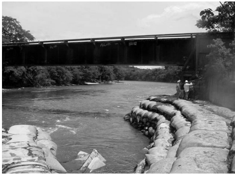
Figura 68. Obras de protección del estribo derecho aguas arriba. Puente Orito
