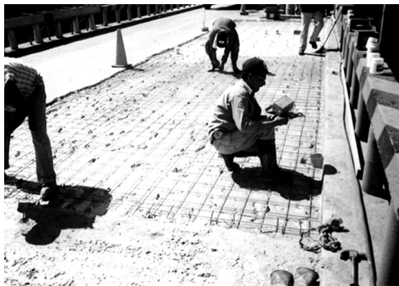
Figura 42. Refuerzo de losa existente con sobrelosa. Puente Río Negro.
