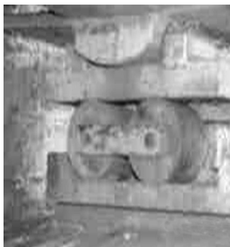
Figura 34. Apoyos sin lubricar. Puente Icel Mocoa (Putumayo)
