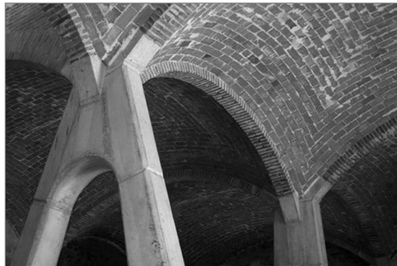
Figura 1. Sistema de apoyo de bóveda sobre pilares de hormigón Figure 1. Vault system supported on concrete pillars
